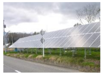
柵塀の設置されない設備
