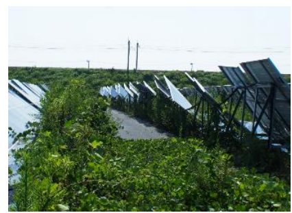
不十分な管理で放置されたパネル
